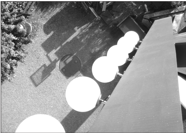
Die Beleuchtung am Turm (o.) und rund um Hotel und Restaurant Uto Kulm ist noch immer nicht bewilligt.
